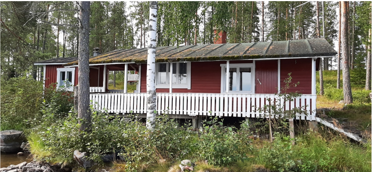
Kuva 2. Purettava lomarakennus Kilpuinsaassa.
